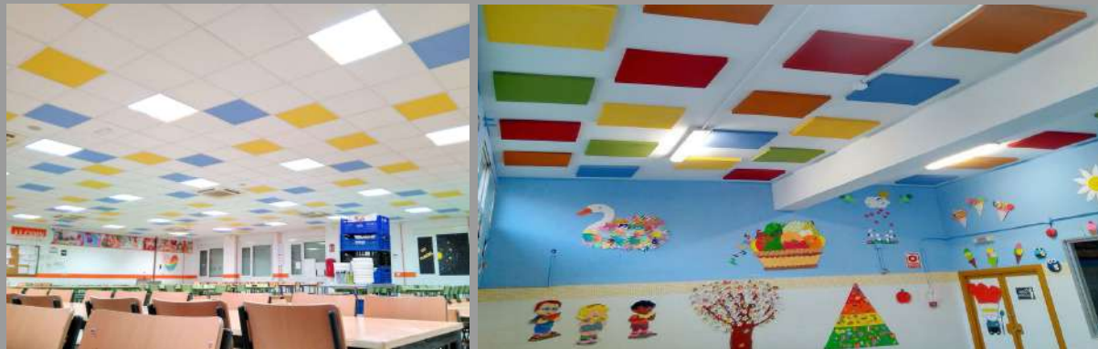
Regular Panel 60.4 Pure sustituyendo placas de yeso en un techo registrable (izquierda) y pegados en el techo (derecha).
