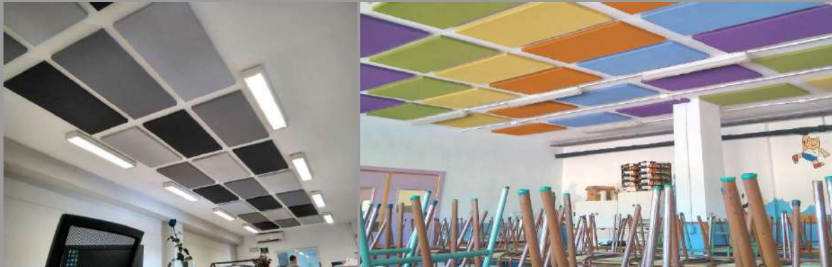
Paneles Regular 120.4 Pure instalados en el techo de una oficina (izquierda) y en un comedor escolar (derecha).
